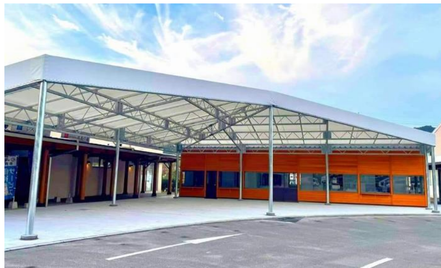
<道の駅テナント棟新設工事> <道の駅交流スペース新設工事>
