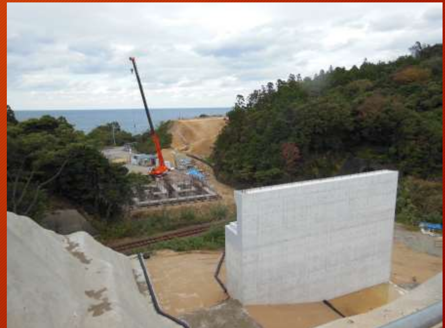
《田部地区工事現場》
