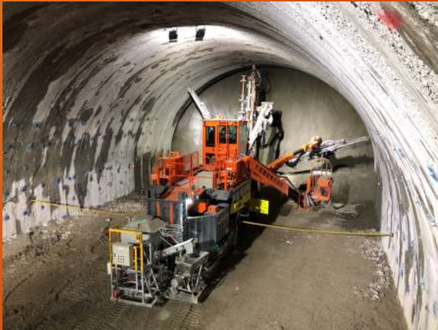
《トンネル掘削工事》
