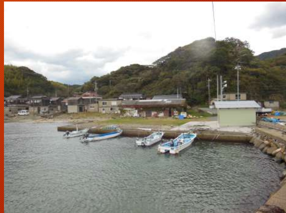
《大敷組合倉庫前の護岸改修工事》
