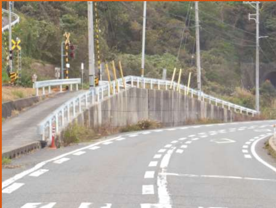
《町道井部田線ガードレール更新工事》
