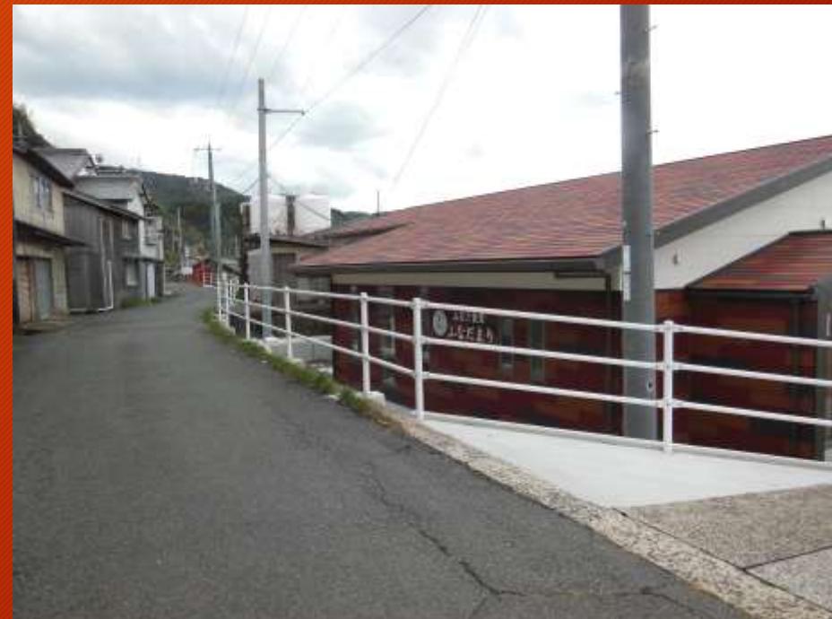
《町道西目今浦線ガードパイプ新設工事》
