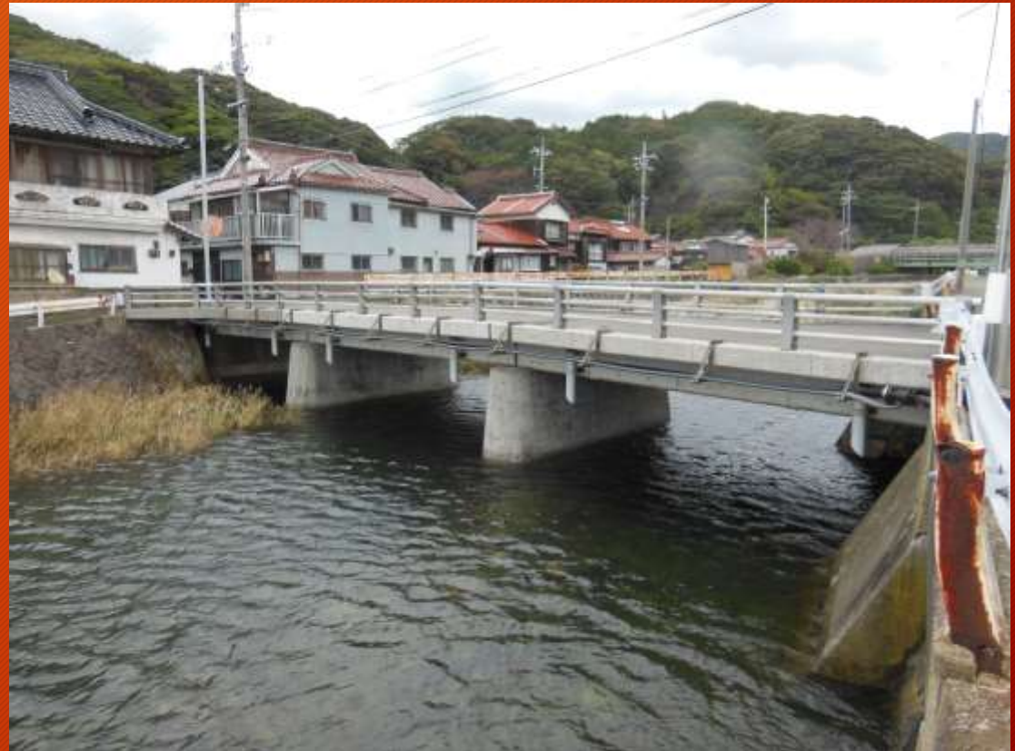
《千歳橋改修工事》
