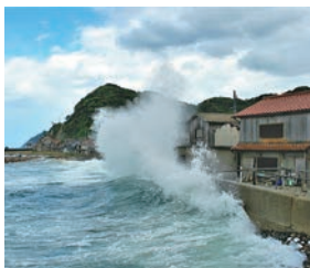
今浦護岸 高潮と荒波 (令和2年9月)
