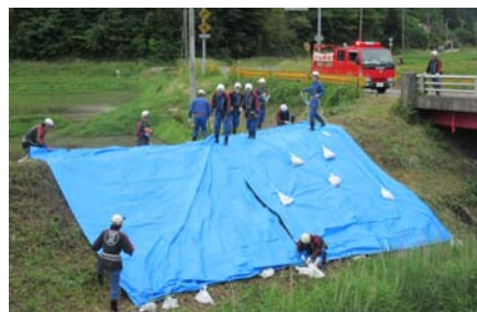
シート張り工法
