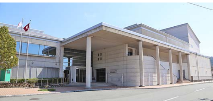
太陽光発電システム等を設置する予定の町民センター
