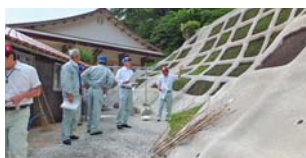
災害復旧工事(芋ヶ迫地区山腹工事)
