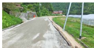
飯谷地区農道拡幅工事
