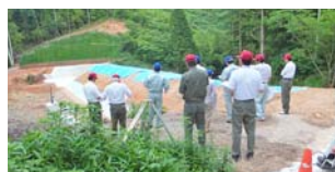
伊豆上ため池改修工事
