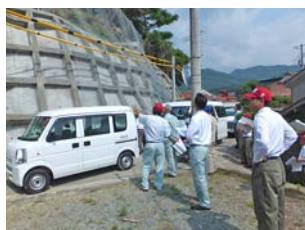
町道宇田中央線 法面安定対策工事
