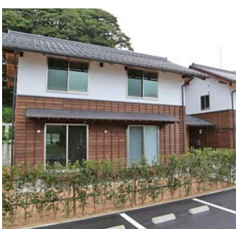
宇田中央地区町営住宅
