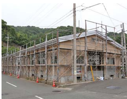
改修工事の進む阿武町武道館
